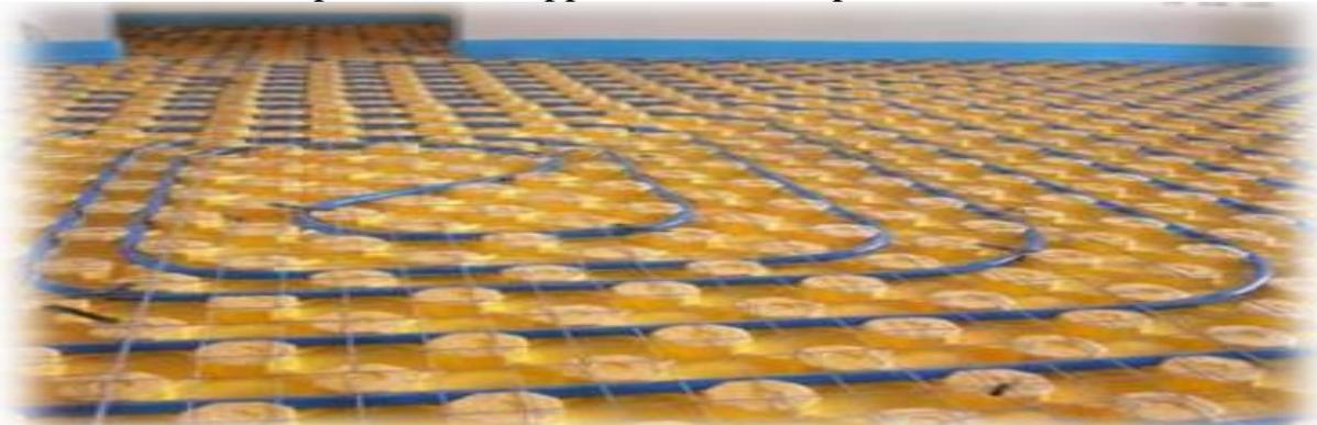
Pavimento riscaldato poggiante su pannello bugnato spessore nominale mm 30+20 tubazione mm 17 spessore mm 2 passo 10-15 su tutti i locali abitabili.
